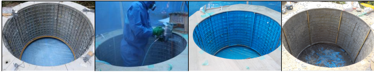
(1) グリッド筋設置 (2) 浸透性接着剤塗布 (3) 付着用接着剤塗布 (4) PCM1層目吹き付け
