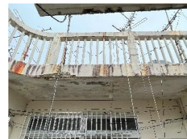
写真-9 調査箇所 No. 4 下部
