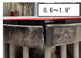
写真-5 吹き抜け鉄板部
