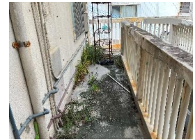
写真-8 調査箇所 No. 6 上部
