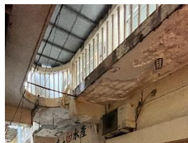
写真-3 調査箇所 No. 2 下部
