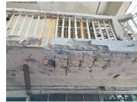
写真-7 調査箇所 No. 6 下部
