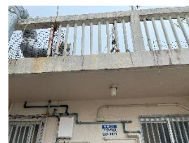
写真-10 調査箇所 No. 5 下部
