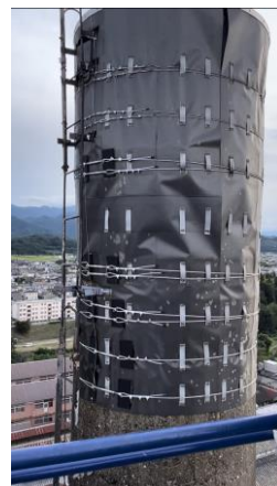
写真－9 煙突頂部の炭素繊維シートカバー
