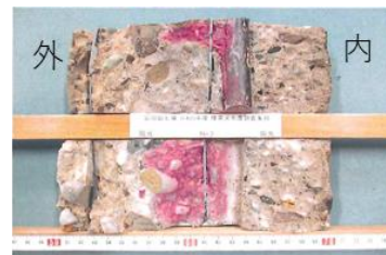
写真-5 コア試験体 No. 3 中性化測定状況
