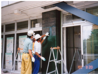
写真-3 柱の炭素繊維巻き補強 （2001年）
