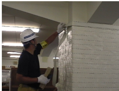
写真-4 柱のポリエステル 繊維巻き補強（2004年）
