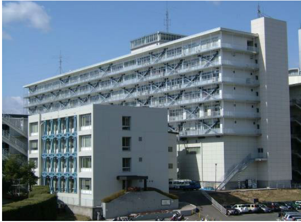
写真-1 建物全景（南側・奥の建物）
