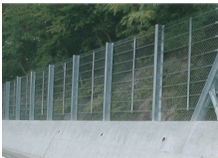
写真-1 擁壁天端に設置される従来型落石防護柵の例
