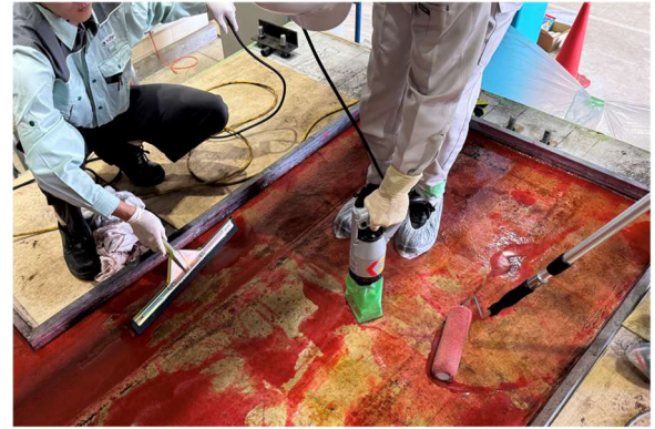
(2) 高浸透型防水材料の塗布
