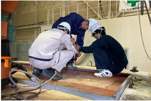
(1) 浸透道の削孔
