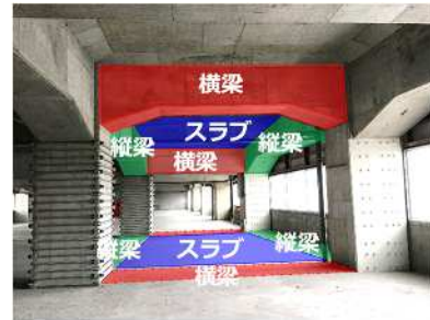
図-2 ラーメン高架橋の中層階の状況
