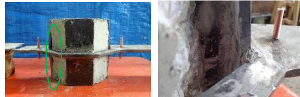
(a) No.4 全体 (横) (b) 柱ウェブ溶接部(コンクリートを研った後)
