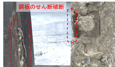
写真-1 コンクリート研り出し状況 BR40-C130-1
