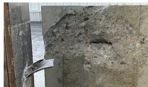
写真-2 コンクリート研り出し状況 BR40-C130-CX
