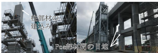
写真-1 フルプレキャスト鉄道ラーメン高架橋
