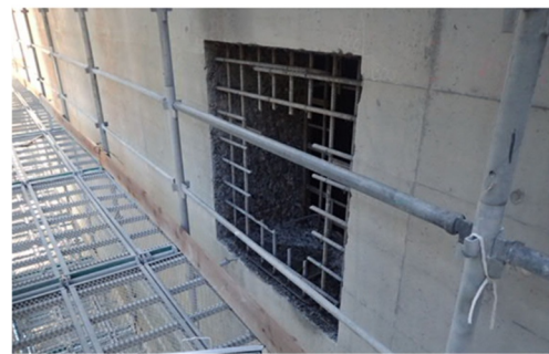
写真-1 中空内部への充填用の孔
