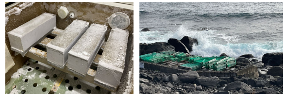
写真-1 鉄筋腐食試験の状況
