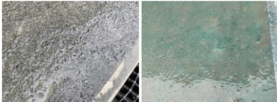
写真-12 降雨後の試験体表面 (左：散布なし，右：散布あり)
