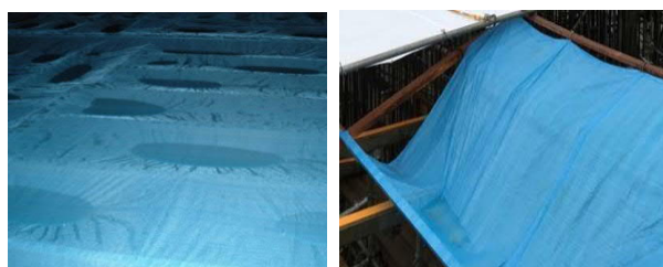
写真-1 ブルーシートによる降雨対策の事例
