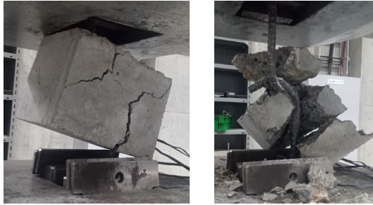
写真-2 Hook-3φ 荷重の様子 (左: ひび割れ開始, 右: かぶり剥落)
