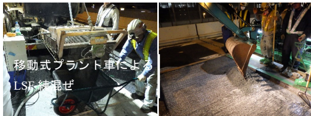
写真-5 LSFの打設工
