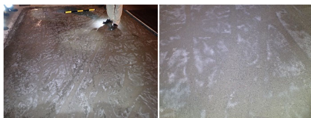
写真-7 LSF施工後の状態（3時間養生後）
