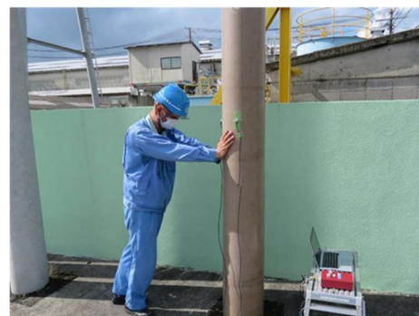
写真-3 作業員による振動の載荷方法
