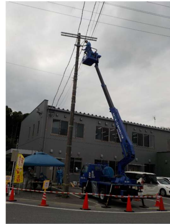
写真-2 振動計測に用いた供用柱
