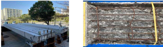
写真-2 PC実橋梁から切り出した桁部材
