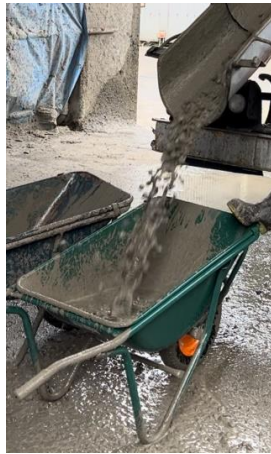
図-4 アジテータ車からの試料の採取状況
