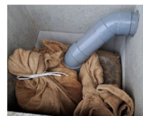
写真-5 材料の設置状況
