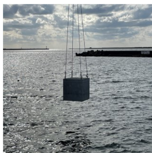
写真-6 ブロックを海中に沈める様子
