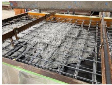
写真-3 打込み状況
