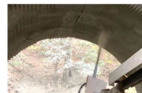
写真－9 コンクリートの吹き付け状況
