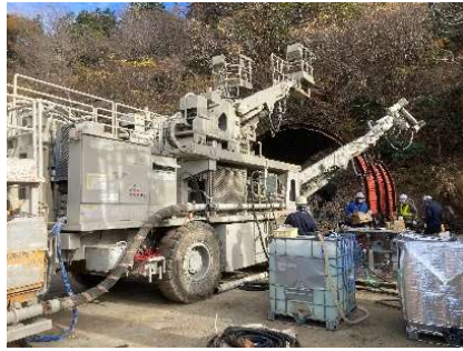
写真-2 吹付け機
