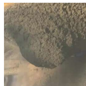
写真-16 吹付け状況 W/C35% 15℃
