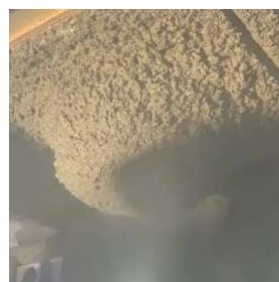
写真-15 吹付け状況 W/C40% 20℃
