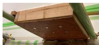
写真-6 天端の吹付け面
