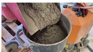
写真-2 モルタルのホッパーへの投入
