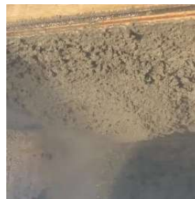
写真-13 吹付け状況 W/C40% 10℃
