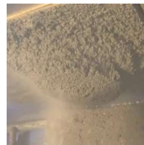
写真-14 吹付け状況 W/C40% 15℃
