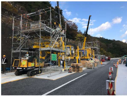
移動式ミキサ2台 (1.0m³練り)
