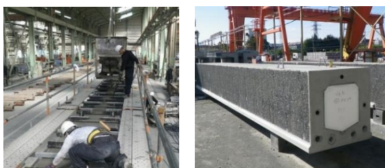
写真-2 締固めを必要とする高流動コンクリート
