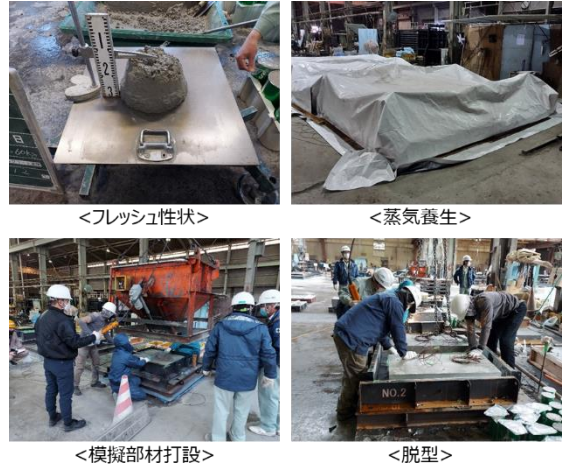
写真-2 コンクリート製造と模擬部材の作製状況
