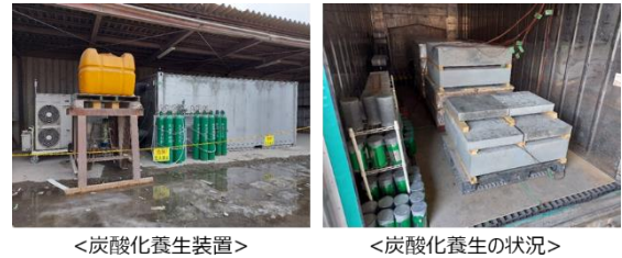
写真-1 大型コンテナ式炭酸化養生装置と養生状況
