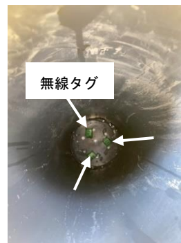
写真-4 塩化ビニール管内部
