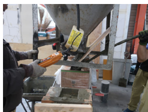
(c) コンクリート打込み状況
