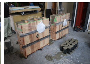
(d) コンクリート打込み後
