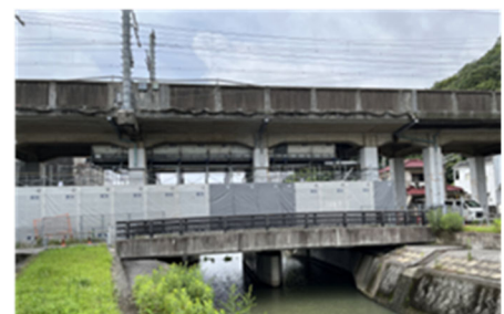
写真-1 現場環境
