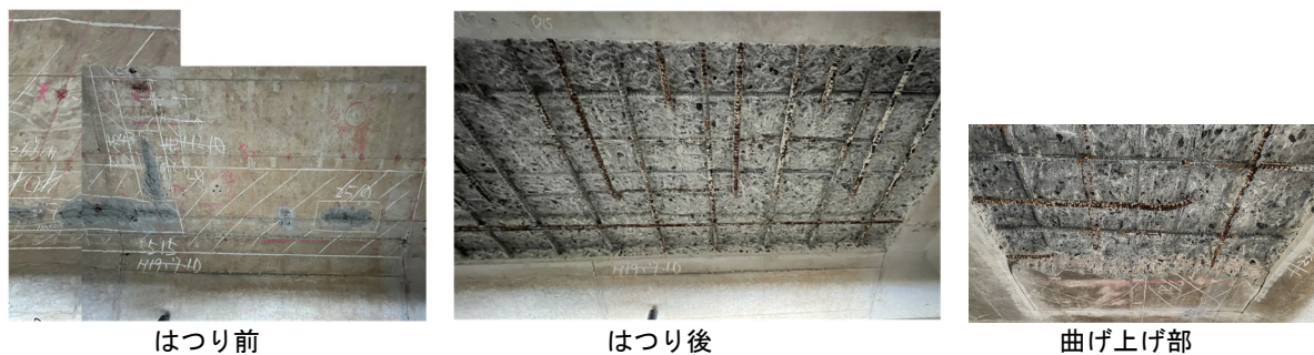
写真-4 中間スラブ下面（中央径間 位置：図-2【2】）
