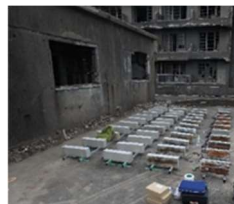
写真-1 69号棟屋上設置
