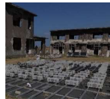
写真-2 70号棟グラウンド設置状況
