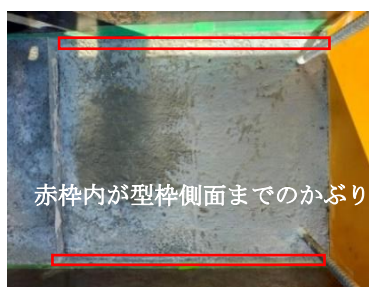
図-5 粉体タイプのかぶり厚さ1cmの塗布状況
