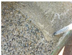
図-1 レイタンス除去を行った面と平滑な打継面
