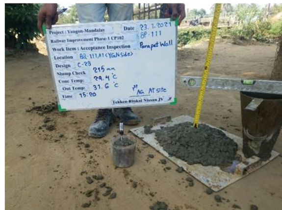
写真-1 スランプ試験状況の例 (ミャンマーの例)
