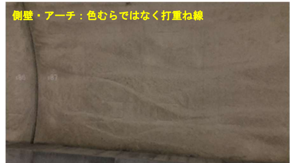
図-8 色むらと打重ね線の評価が難しい事例2
