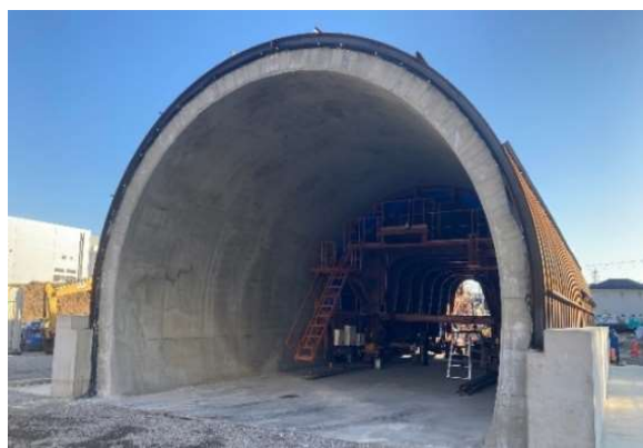
写真-1 脱型後の覆工コンクリート外観
