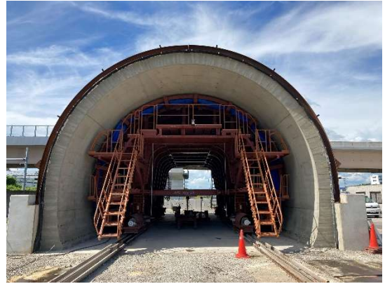
写真-2 脱型後のコンクリートの外観
