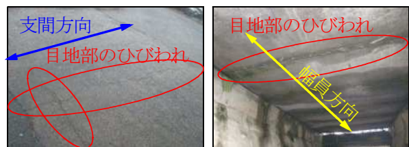
1) 上面 2) 下面 (1) 既設プレキャスト床版橋
