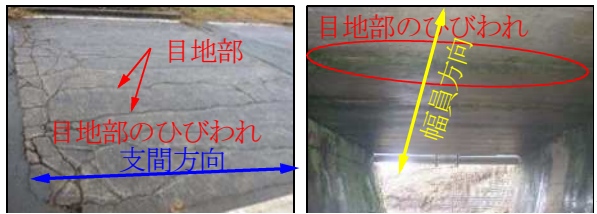
1) 上面 2) 下面 (2) 既設プレキャスト床版橋
