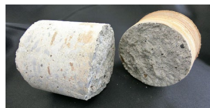
a) PA-1 のコンクリート内のせん断破壊
