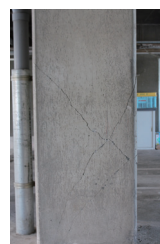
(1) 損傷度IIIのRC柱 (2) 余震に備えた応急補強 写真-2 RC造共同住宅のピロティ柱の地震被害例
