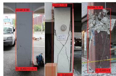
写真-1 DNNによるRC柱の損傷度の推定 1)
