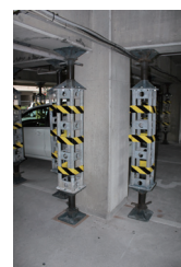
(1) 損傷度IIIのRC柱 (2) 余震に備えた応急補強 写真-2 RC造共同住宅のピロティ柱の地震被害例
