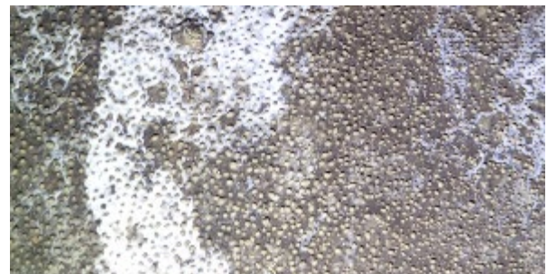
図-4 防食被覆層の表面の様子
