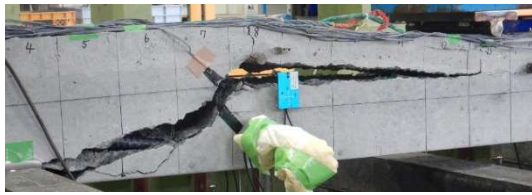
図-5 荷重中の斜めひび割れの開口・進展 (Case 1)
