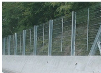
写真－1 擁壁天端に設置される従来型落石防護柵の例
