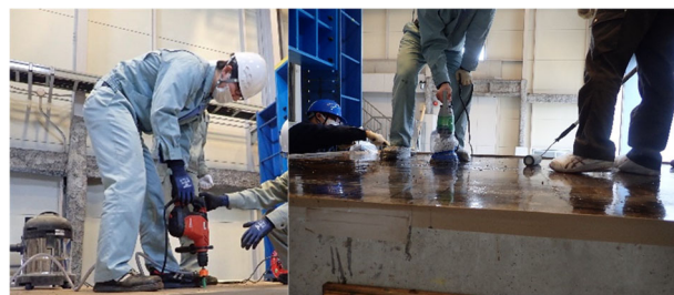
(a) 削孔状況 (b) 塗布状況
