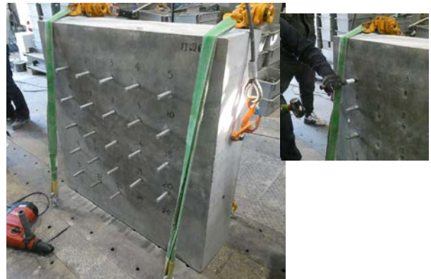
(b) 横向き施工
