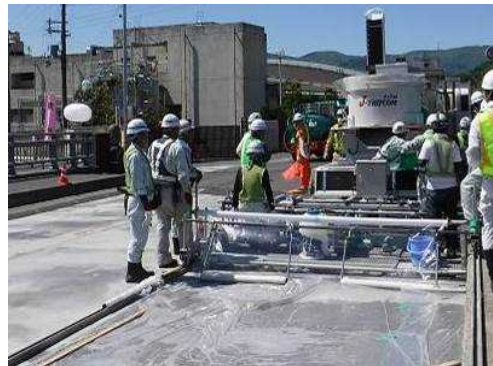
写真-2 UHPFRC による床版補修
