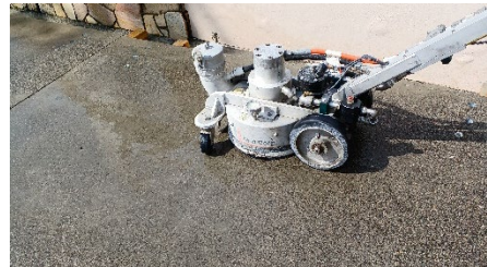
写真-1 供試体の WJ による表面研掃状況
