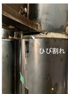
(b) 柱頭部の空隙
