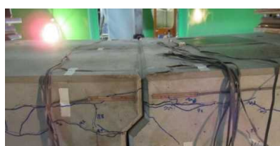
写真－3 No. 3 接合部圧壊の状況
