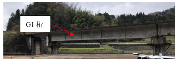
図-1 PC 桁の外観
