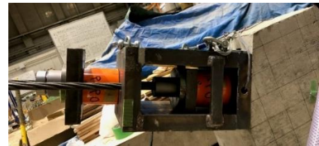
写真-2 端部緊張力の計測状況
