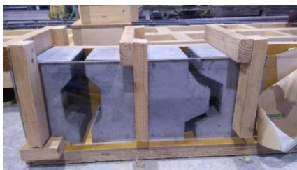
写真-1 型枠組立状況
