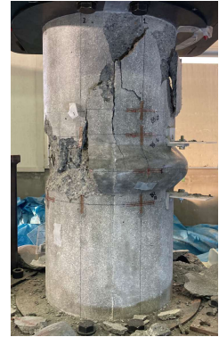
写真-2 最終破壊状況
