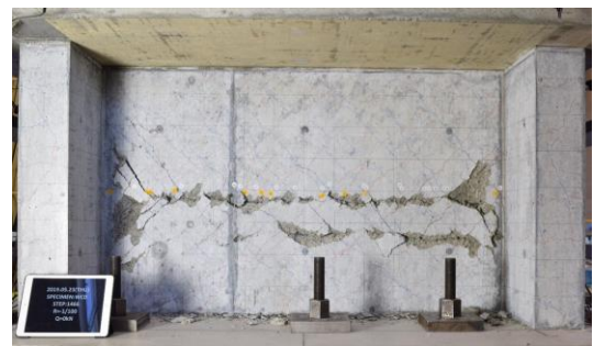
図-7 試験体 WCD-A の破壊状態
